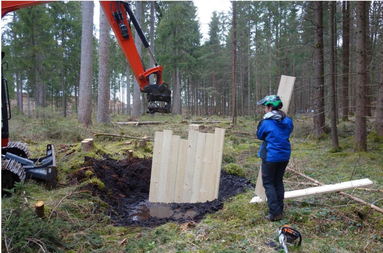
Abbildung 22: Moornaturierung in der Zinsenhalde, Einbau einer Spundwand in ein Dammbauwerk (Foto: H. Heintl)
